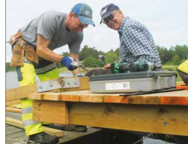
Arbetsledaren Nisse och Tomas i renoveringsstegen med stugbryggan på Kålö.
