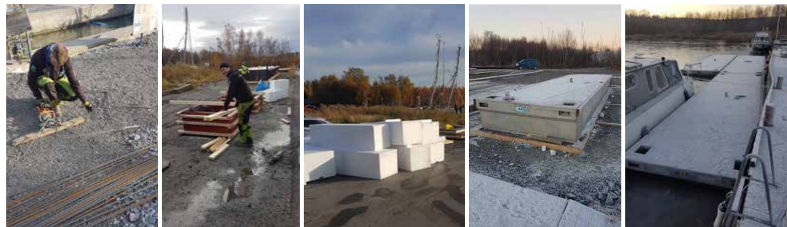
Bryggentreprenören har som ni kanske sett tillverkat de nya pontonerna nere vid kajen. Foto Gunnar Schrewelius
