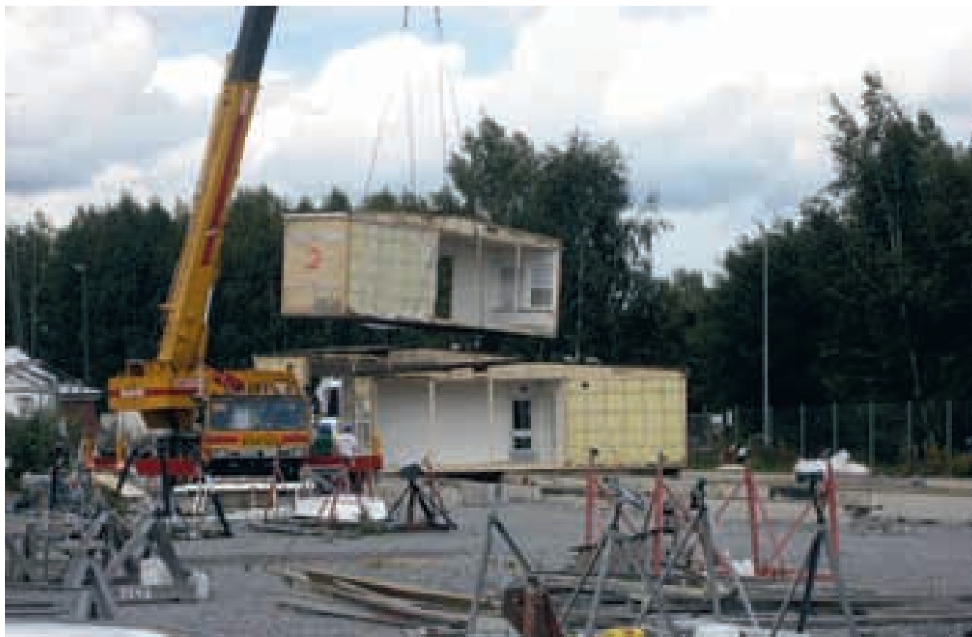
Några av de 12 modulerna lyfts på plats.
