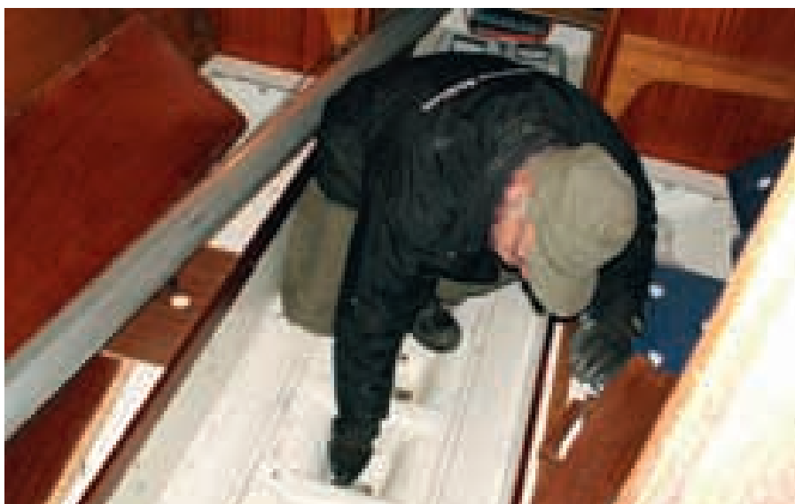
Kontroll av bottenstockar på en Albin Express.
