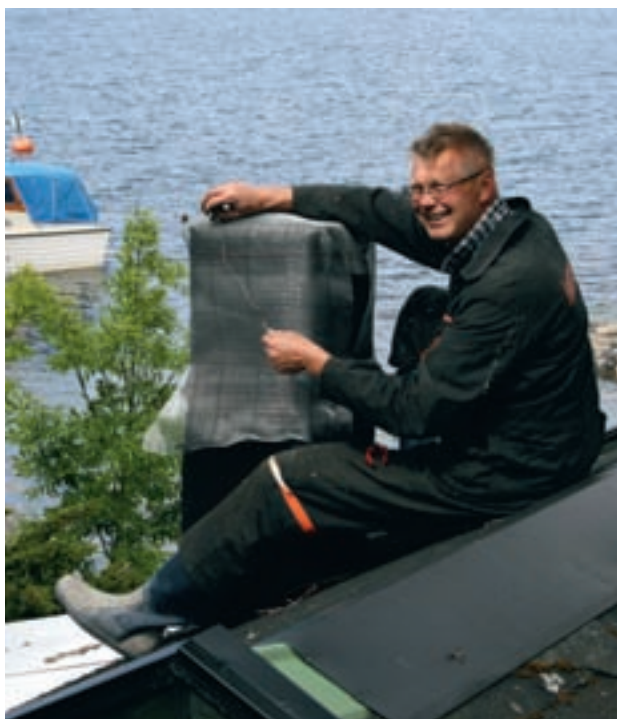
Tomas Nilsson monterar nytt gnistnät på bastuskorstenen.
