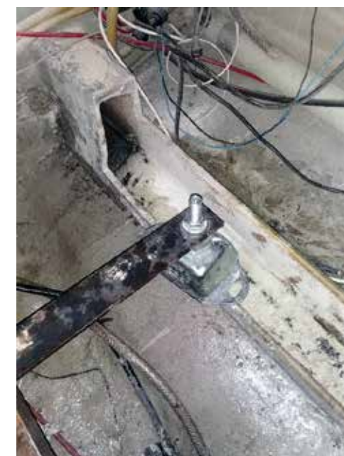
Professionell hjälp togs in för att plasta upp en ny motorbädd med inplastade förstärkningar av järn med pinnbultar för motortassarna.
