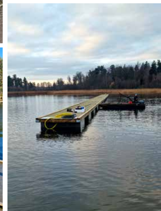
9 november skiftades den inre delen av brygga 3 i Runöhamn ut mot en ny del.
