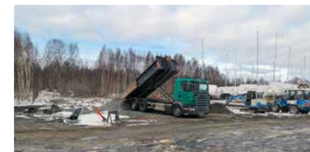
Bygget av spolplattan har påbörjats (i aprilväder).
