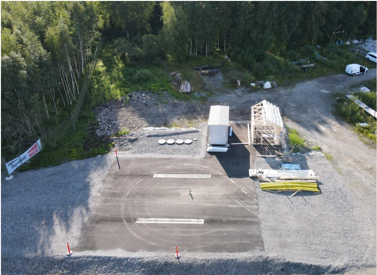
Spolpattan efter asfaltering, färdigställande av filterhus och redskapsbod pågår.
